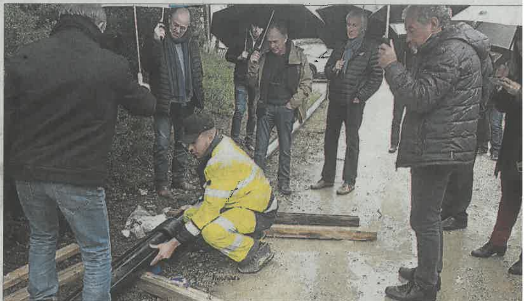
■ Les officiels ont assisté à la thermosoudure d'une conduite en polyéthylène par les techniciens
